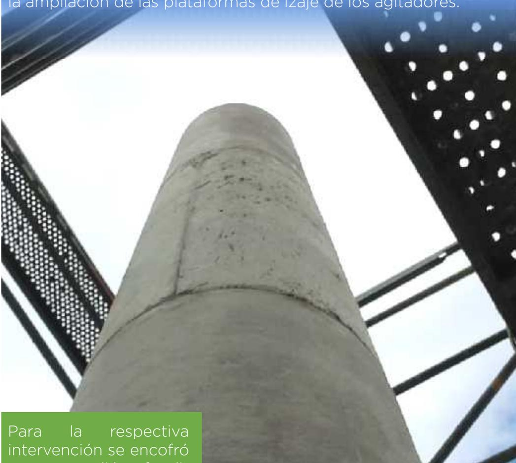
Para la respectiva intervención se encofró y se procedió a fundir en concreto la columna y plataformas.
