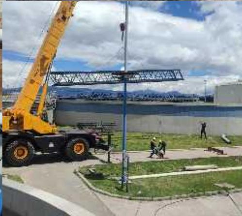
Se realizó la fabricación y montaje del puente del espesador y se inició el refuerzo del puente existente en este mismo tanque.
