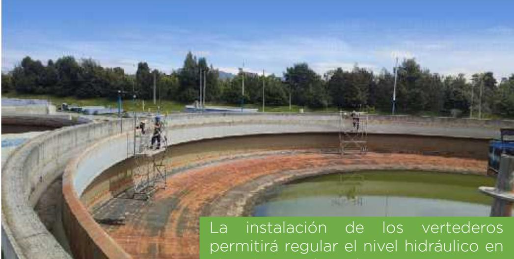
La instalación de los vertederos permitirá regular el nivel hidráulico en el perímetro de cada tanque.
