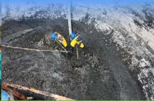
Este proceso de vaciado se llevó a cabo por medio de una bomba sumergible de lodo, retirando el sólido por medio de Vector.
