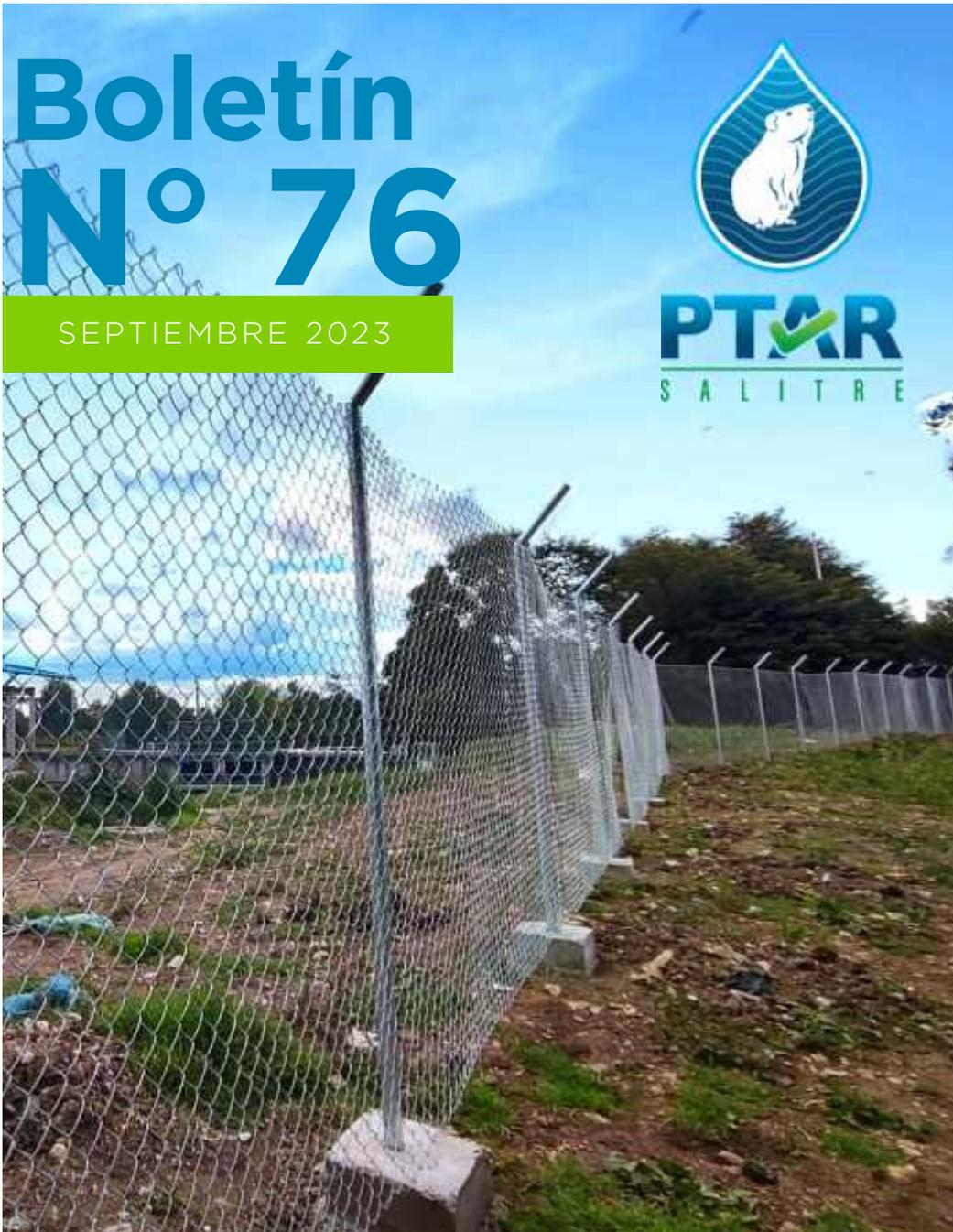
Se avanza en la ejecución del cerramiento del Interceptor 1B, completando la instalación de postes metálicos y malla eslabonada que se utilizará para delimitar el predio.
