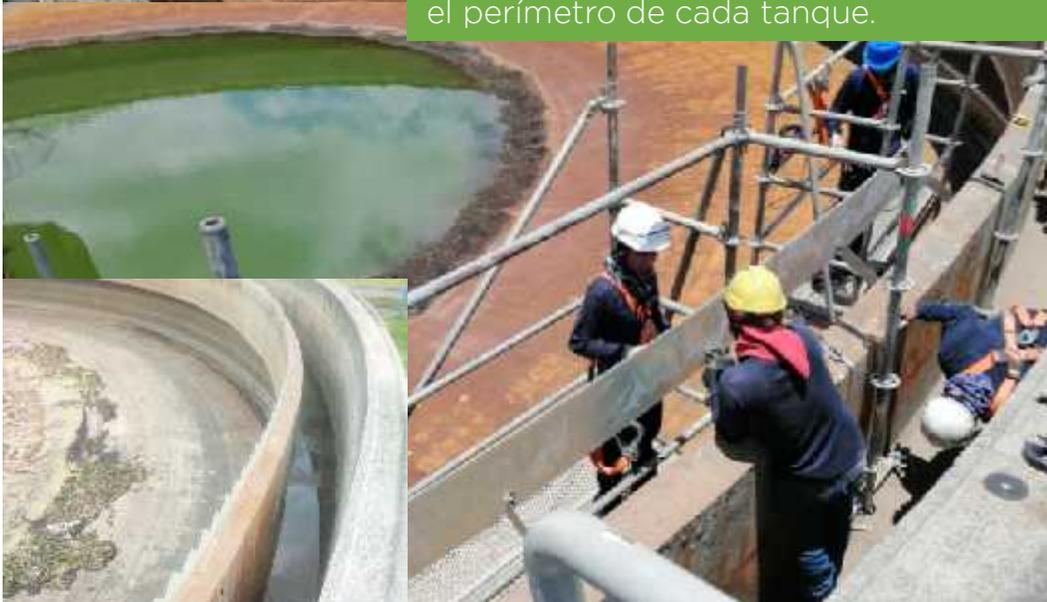
El montaje de los deflectores posibilita la detención de los flotantes al interior de los decantadores primarios, evitando así que lleguen a los tanques biológicos.
