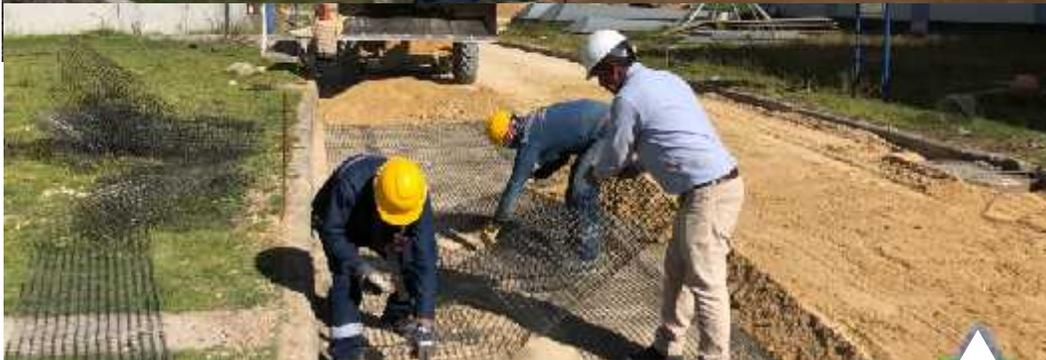
Se termina con la revisión de los niveles de la base y se continúa con la instalación de la malla biaxial y la compactación de la base.
