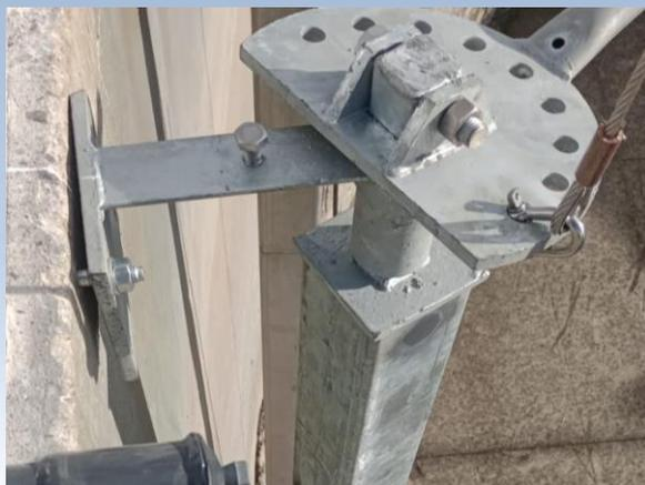
Instalación de los soportes guía para los agitadores del tanque.
