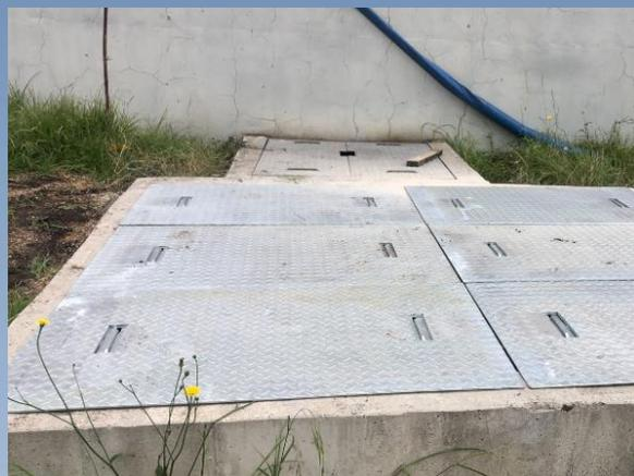
Estado final de la caja de válvulas con sus respectivas tapas según las especificaciones técnicas.
