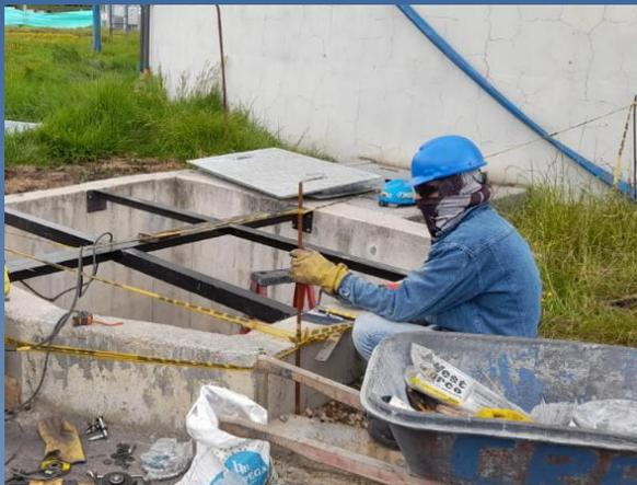
Proceso de instalación de la estructura de apoyo y las tapas en la caja de válvulas que permiten enviar el lodo digerido al proceso de deshidratación.
