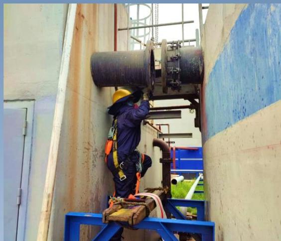
Finalizan las actividades de la conexión de las tuberías que alimentan y succionan el lodo entre los espesadores y el edificio de tamizado.
