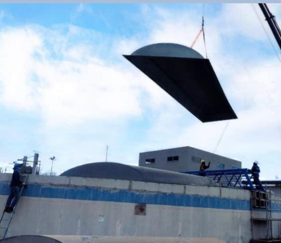
Se dio inicio a la instalación de la cubierta en fibra de vidrio que evitará la proliferación de olores provenientes de las estructuras de los espesadores.
