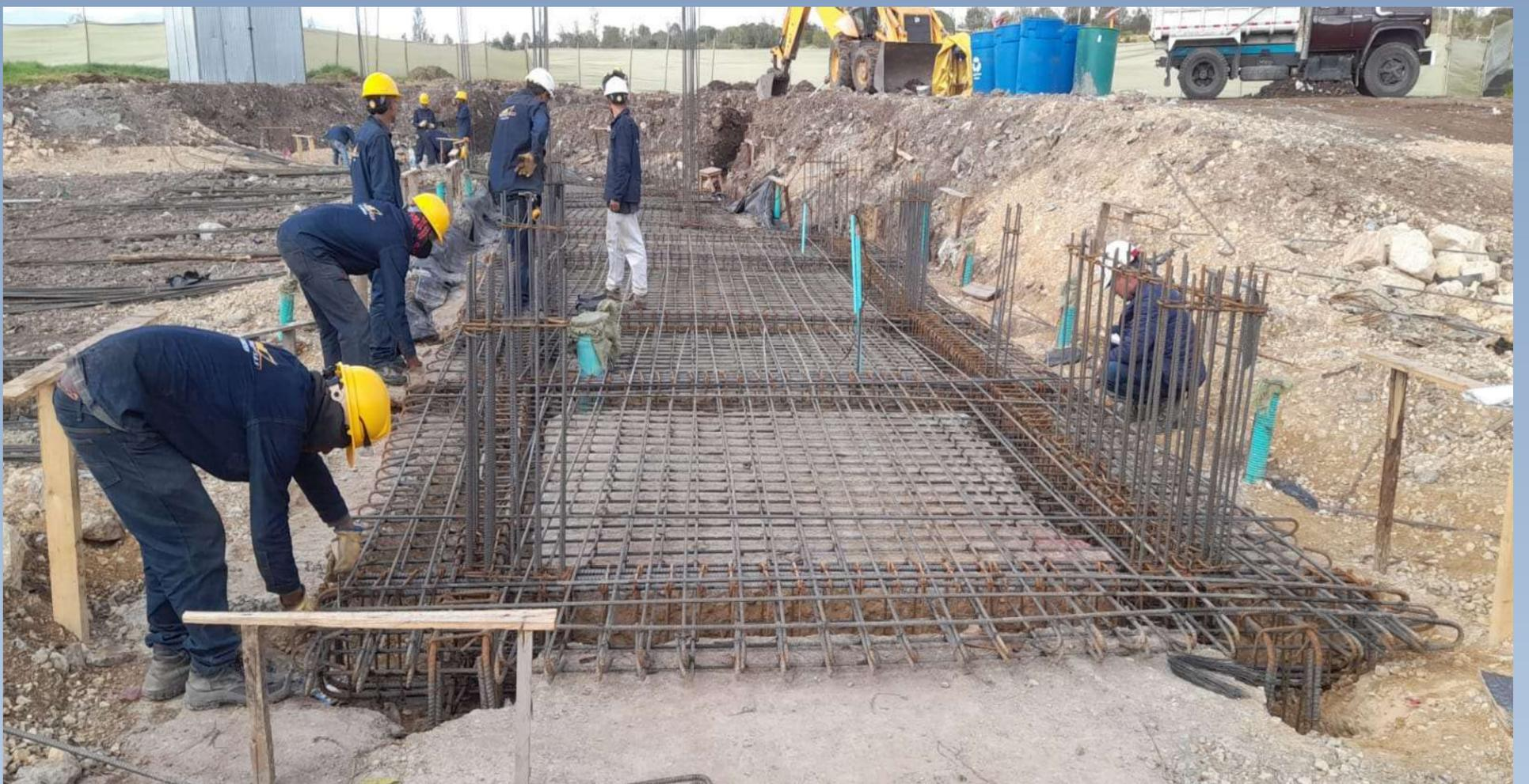
Proceso de fundida de concreto de limpieza, el cual aísla el material granular de la estructura de cimentación.
