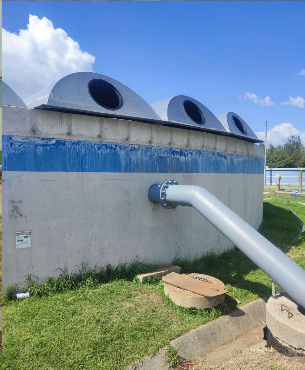
Se culminó el proceso de soldadura y recubrimiento con pintura epóxica resistente a la corrosión.
